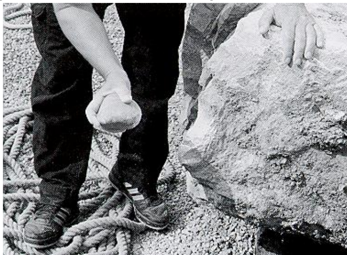
Figure 2 : Bouchardage de la dalle de couverture et confection d'une encoche au percuteur de pierre (cliché A. Digneffe)
