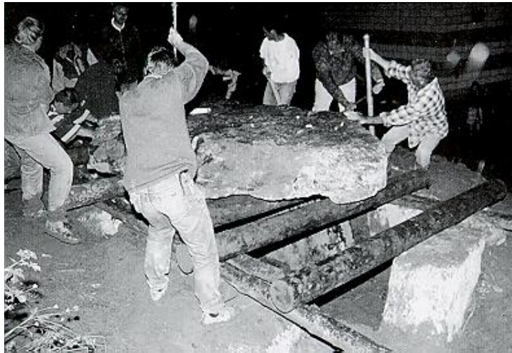
Figure 10 : La dalle avance sur l'allée, propulsée par les rondins sous elle. (cliché M. Toussaint)
