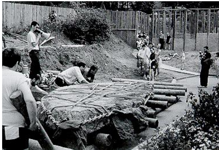
Figure 3 : Traction de la dalle de couverture; l'allée mégalithique se situe sur la gauche du cliché (cliché M. Toussaint)
