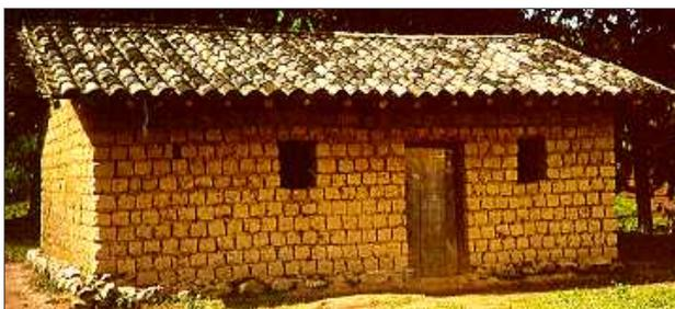
Une fois sèches, elles sont assemblées au moyen d'un mortier de terre humide. Une armature de bois est parfois utilisée en renforcement.
